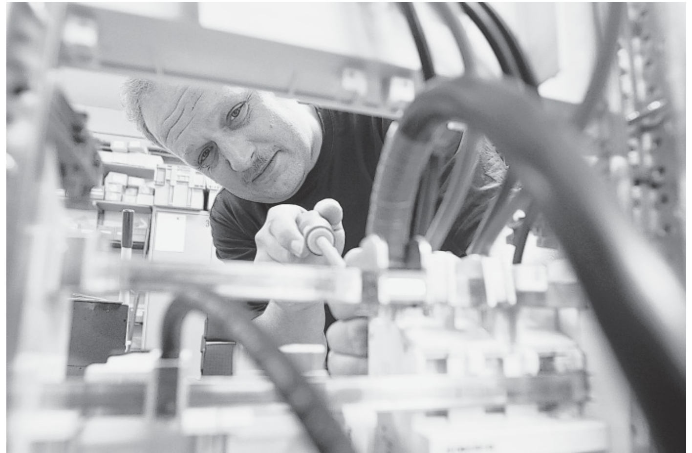
Hat den Durchblick: Elektroinstallateur Claus Rohde baut gerade eine Elektroverteilung für das Königin-Mathilde-Gymnasium in Herford.
