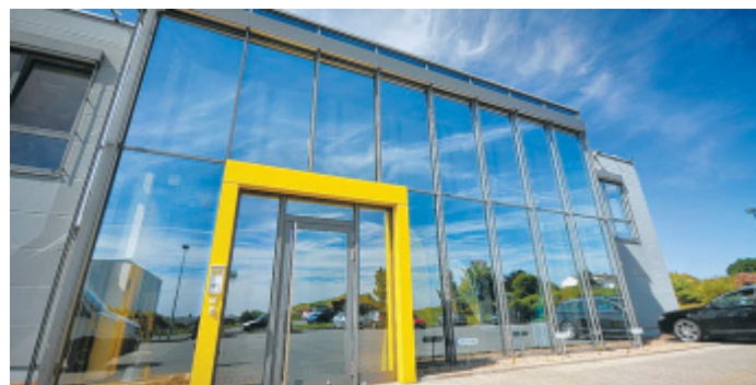
Markante Fassade: Der Haupteingang der Knappe und Lehbrink Promotion GmbH im Ennigloher Industriegebiet.
